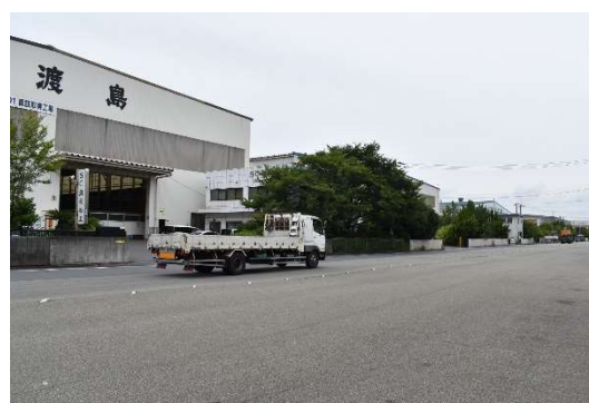
鉄鋼通り・港・千鳥地区工業振興地区 (浦安市)
