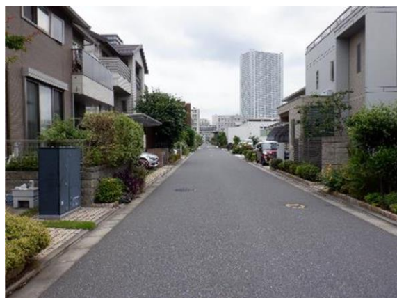
区画整理事業により、無電柱化を実施、良好な景観形成が図られた生活道路
