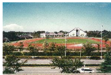
運動公園（中台地区） 出典：千葉県企業局事業の軌跡より
