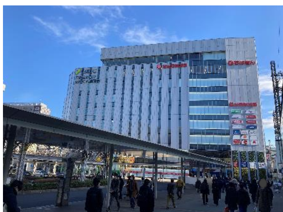
千葉駅東口地区第一種市街地再開発事業（千葉市）
