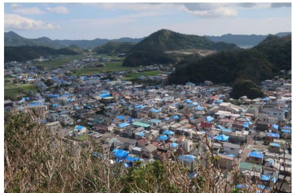
甚大な台風被害を受け、雨漏り防止のためビニールシートで屋根を覆う。 (写真:令和元年房総半島台風)
