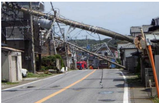
館山市内の台風被害状況
