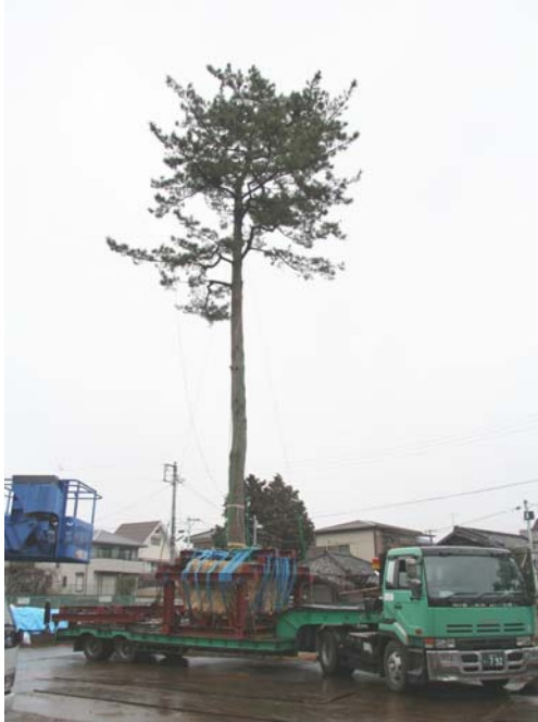
■ トレーラーによる運搬作業
