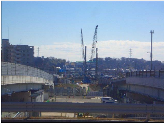
■小山高架橋北（下部工）工事
