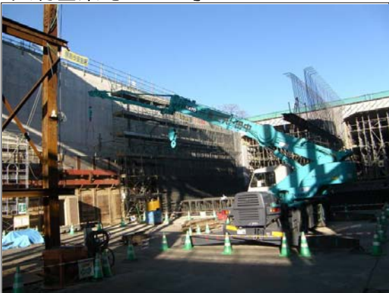
■矢切函渠その5工事
