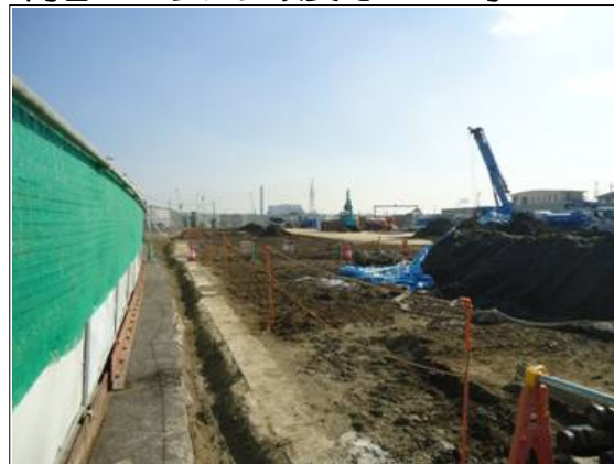
■高谷 | Cランプ改良その4工事
