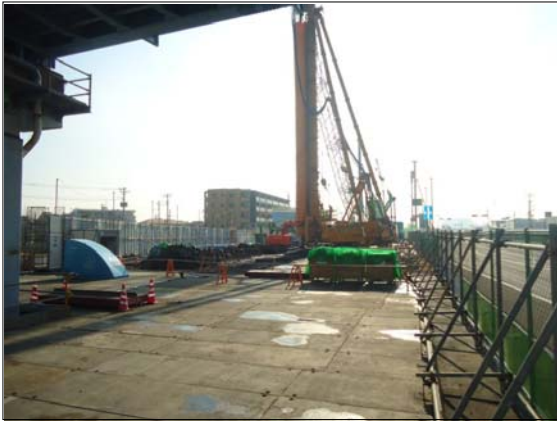
■田尻地区函渠その2工事
