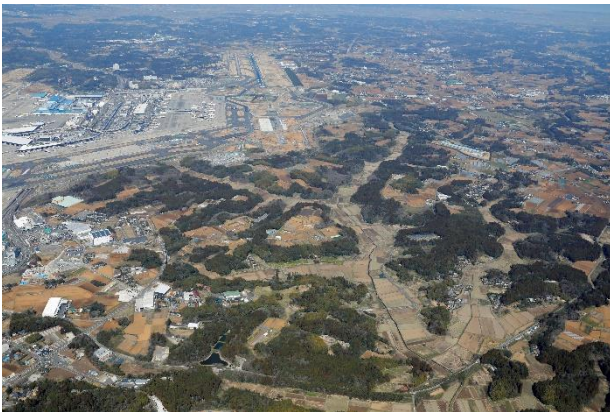
提供：成田国際空港株式会社 成田空港の更なる機能強化により、空港用地の拡張とC滑走路の整備等が行われている成田空港 (写真：成田市/ 成田空港の拡張エリア)
