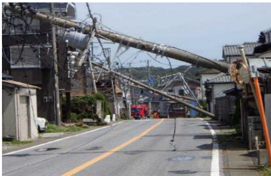
館山市内の台風被害状況
