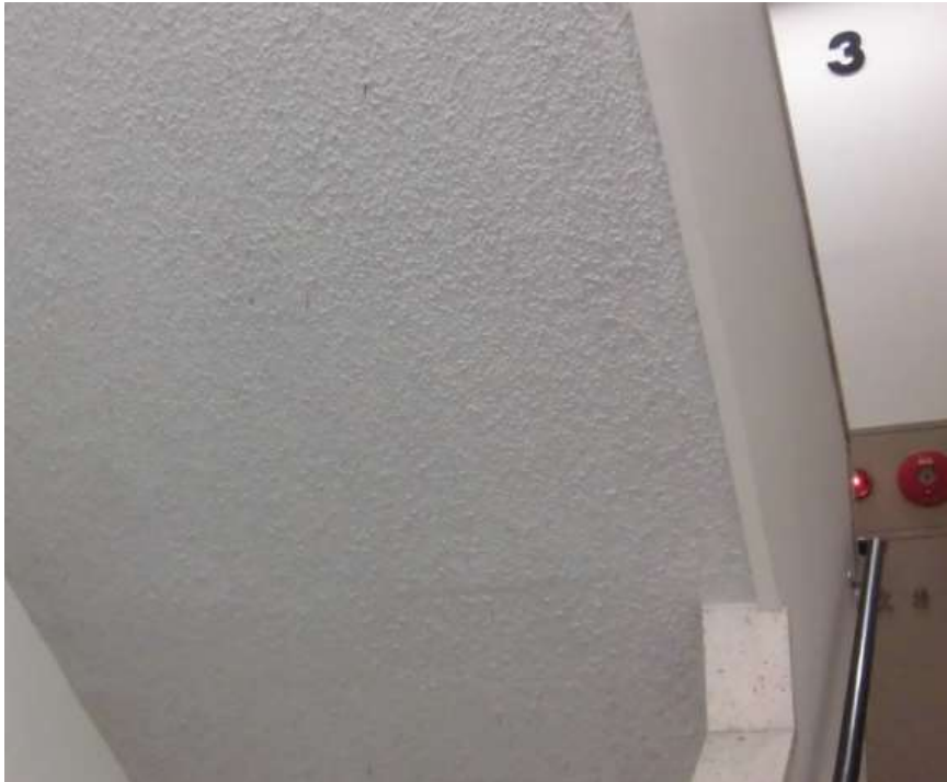
階段の天井（吸音） …塗装をした例
