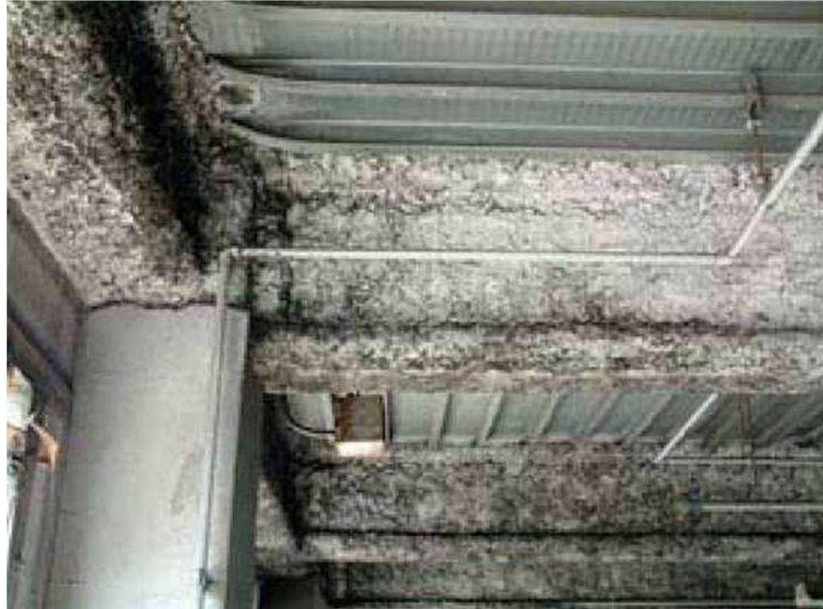
鉄骨造の梁・柱に吹付けた例
