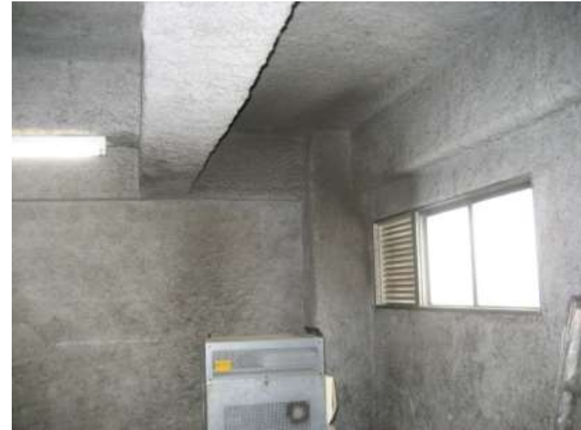
機械室の壁・天井（吸音） …塗装をした例
