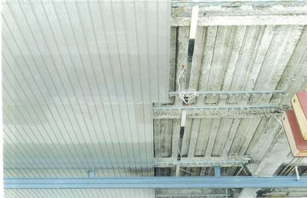
屋根裏用断熱に使用した例
