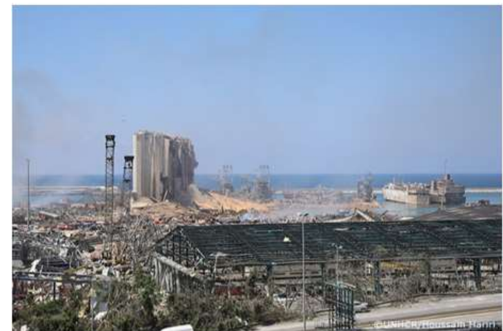
爆発が発生した港湾地域の様子
