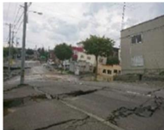
【宅地被害の状況】（札幌市清田区）
