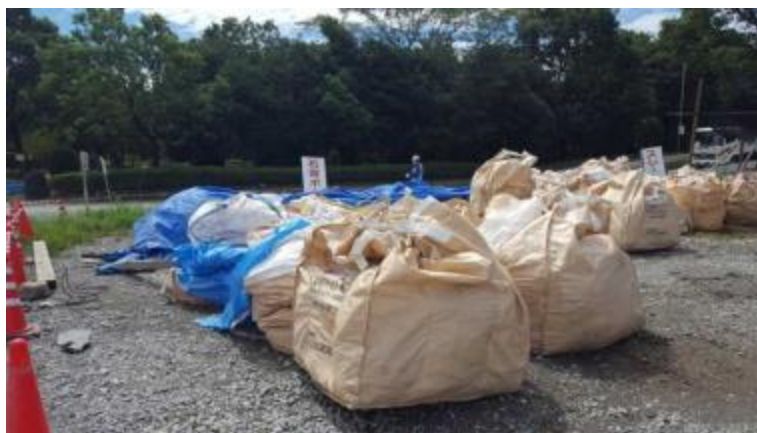
フレキシブルコンテナバッグによる保管状況（一次仮置場）
