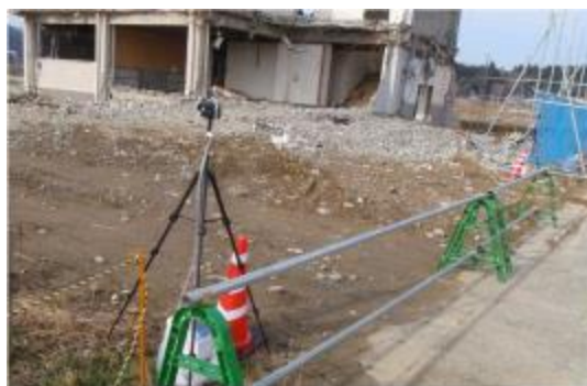
損壊建築物近傍での測定例
