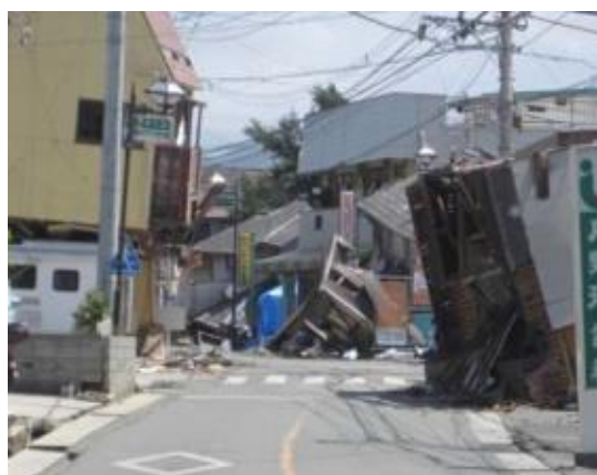
損壊建物（地震）
