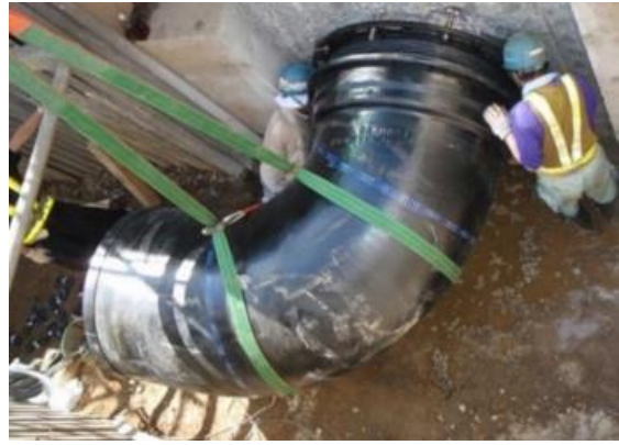
大口径管路の工事状況（シールドマシンの設置（左）・管の布設（右））
