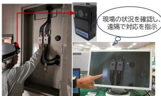
ウェアラブルカメラを活用した施設点検
