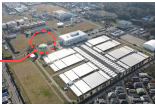
柏井浄水場西側施設洗浄水槽
