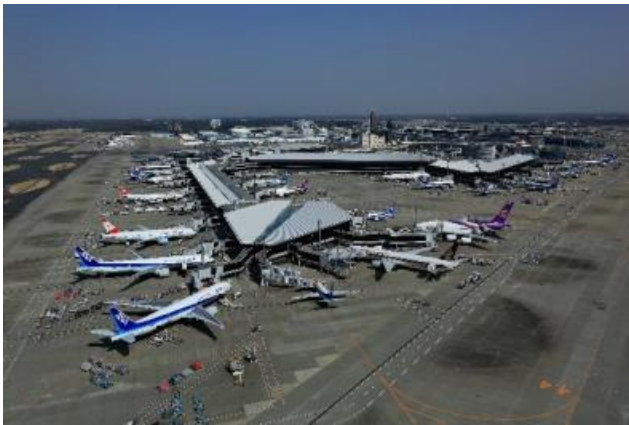
成田国際空港 (成田国際空港株式会社提供)
