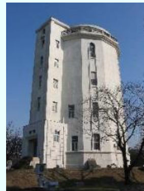
<千葉高架水槽>
