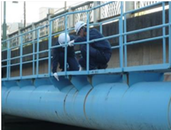
水管橋の点検
