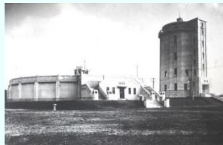
<完成初期の千葉高架水槽と千葉分場1号配水池>
