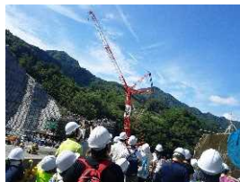
ハッ場ダム建設現場
