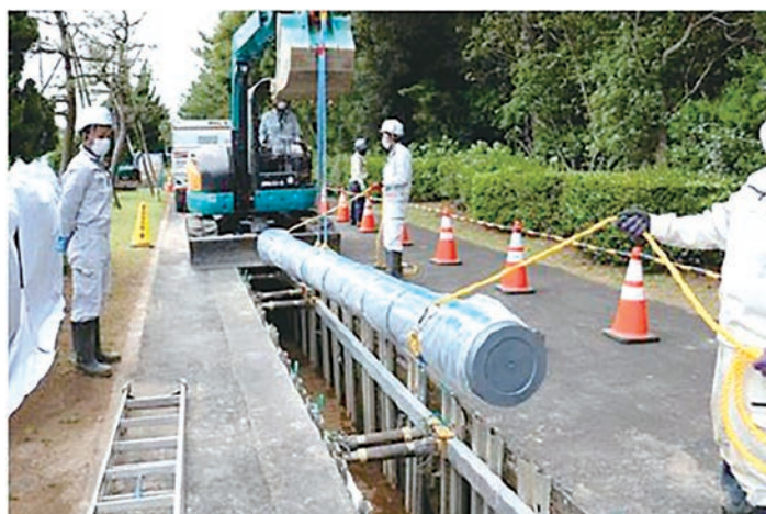
地震に強い水道管に交換する工事のようす
