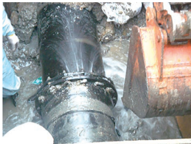
液状化により水道管から水がもれるようす
