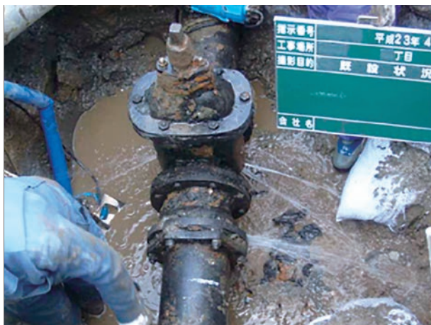
液状化により水道管から水がもれるようす
