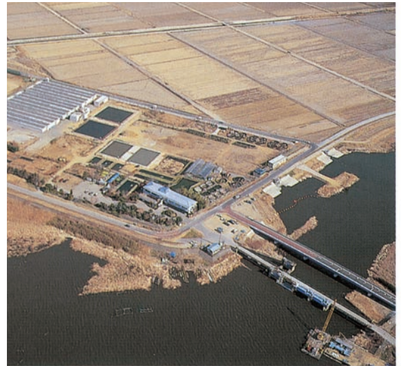
手賀川浄化施設
