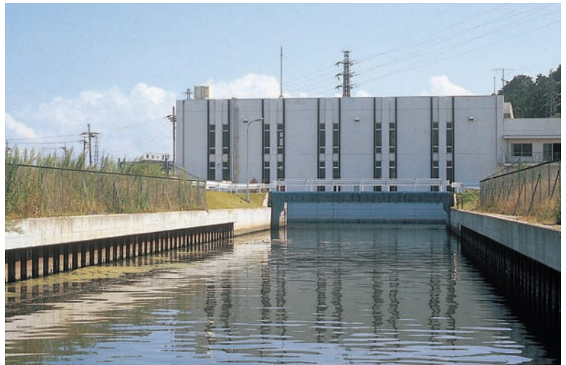
東庄町にある笹川揚水機場
