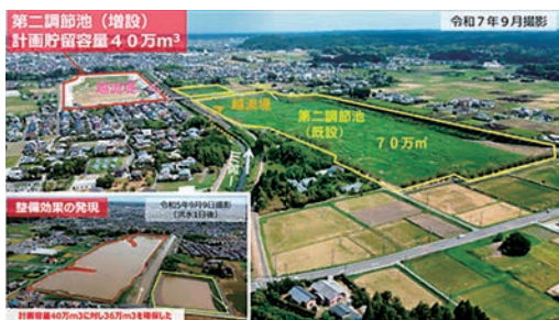
洪水時に一宮川の水を一時的に貯める調節池を増設しました(茂原市)
