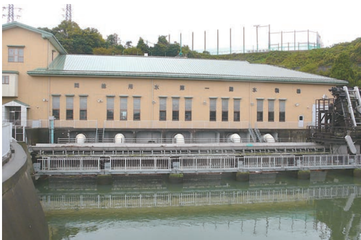
香取市にある両総第一揚水機場
