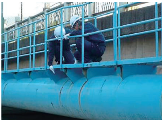
水道管の点検
