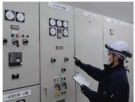
電気設備の点検
