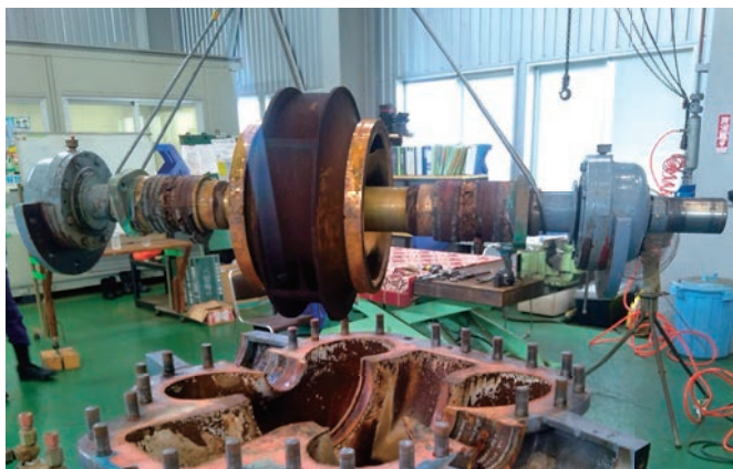
ポンプ設備の修理
