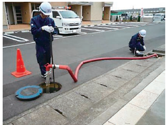
水道管の洗浄
