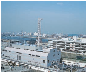
きゅうすいじょう みょうでんきゅうすいじょう ●給水場 (妙典給水場) じょうすいじょう おく た すいそう 浄水場から送られてきた水を貯める水槽があります
