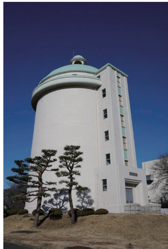
1937(昭和12)年に完成した県営水道の栗山配水塔 (平成18年土木学会選奨土木遺産認定) とうろくゆうけいぶんかざい けんぞうぶつ とうろく (平成29年登録有形文化財(建造物)登録)
