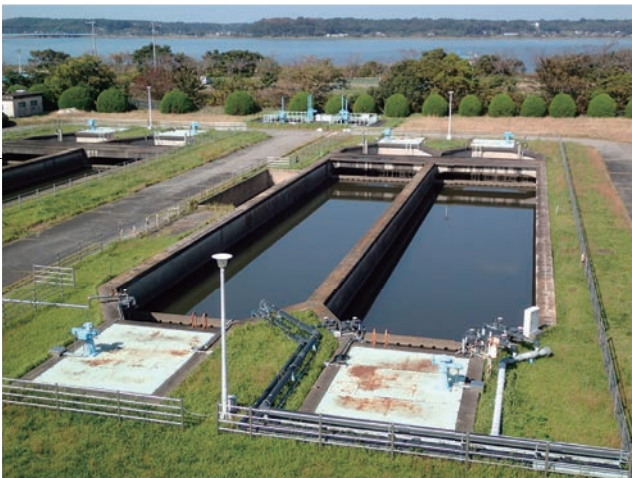
●取水場(印旛取水場)
