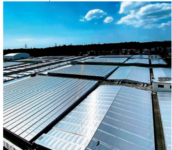
●沈でん池(柏井浄水場)
