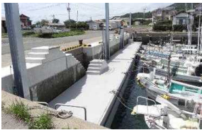
浮桟橋の整備による作業の軽労化
