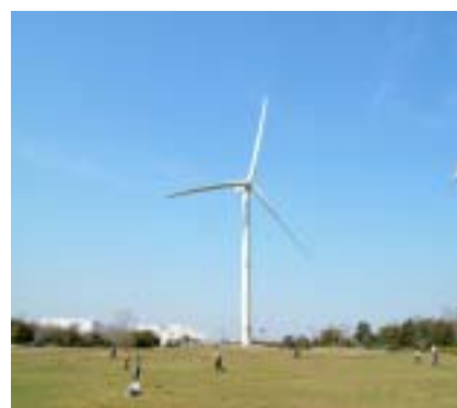
若洲海浜公園 風力発電施設
