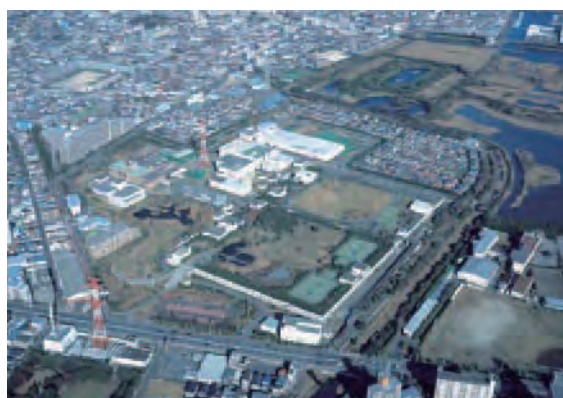
江戸川左岸流域下水道（江戸川第2終末処理場）
