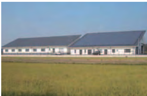
農業集落排水 (山武市大平地区汚水処理施設)
