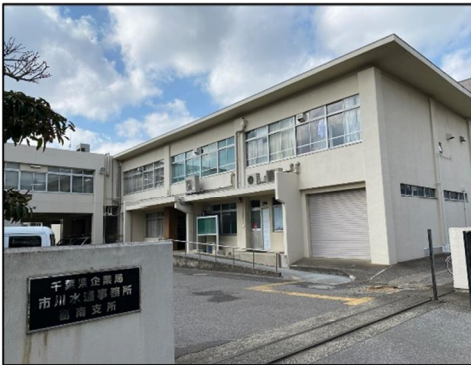
⑪市川水道事務所 葛南支所
