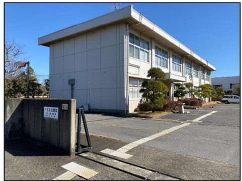
⑧船橋水道事務所 成田支所
