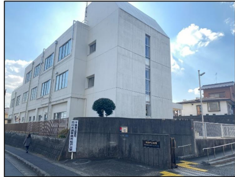
⑩市川水道事務所 松戸分室
