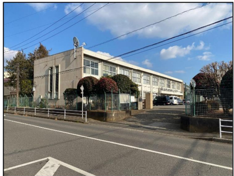
⑥船橋水道事務所 船橋北支所
