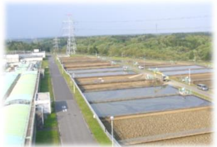
福増浄水場での浄水発生土の天日乾燥
