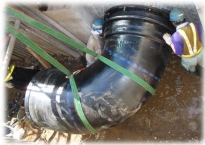
配水管布設替工事
