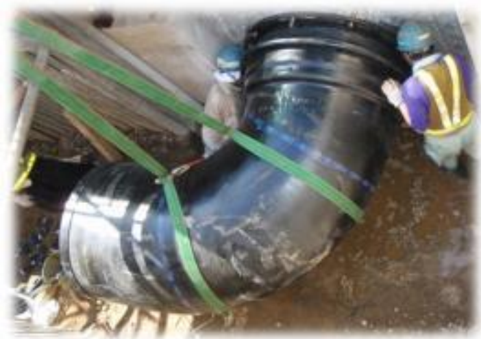
配水管布設替工事
