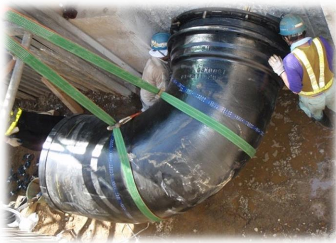
配水管布設替工事
