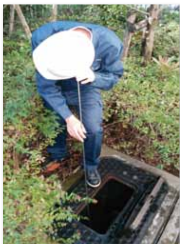
漏水調査：水道管から伝わる音だけをたよりに漏水を見つけます。
