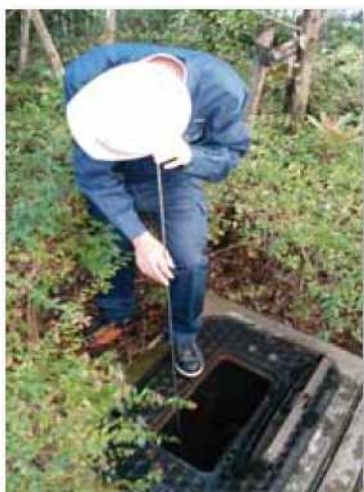
漏水調査：水道管から伝わる音をたよりに漏水を見つめます。
