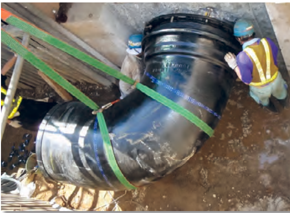
配水管布設替工事
