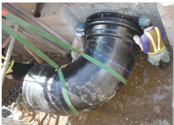
配水管布設替工事
