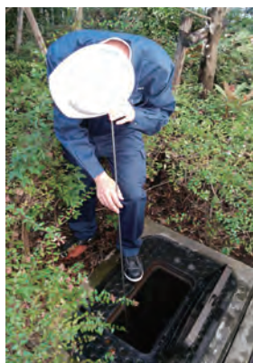
漏水調査：水道管から伝わる音だけをたよりに漏水を見つけます。
