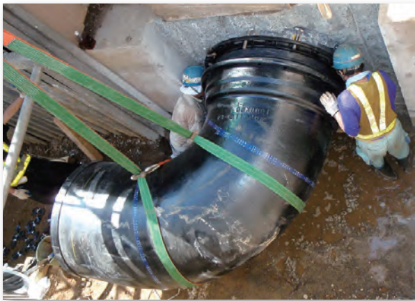
配水管布設替工事
