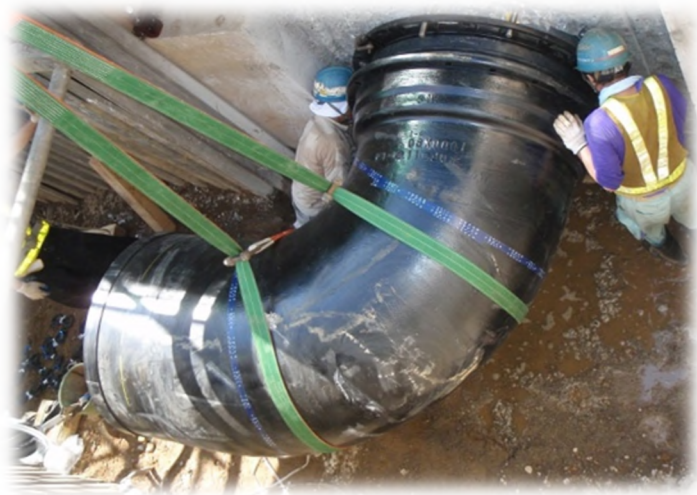
配水管布設替工事
