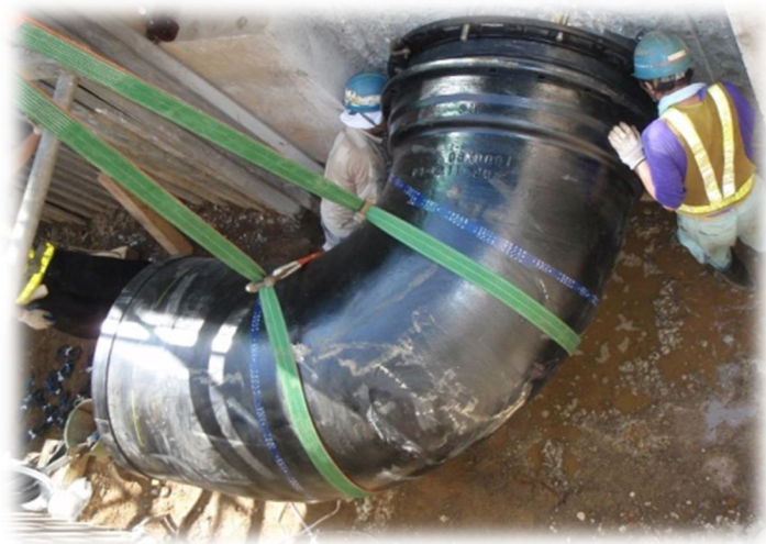
配水管布設替工事
