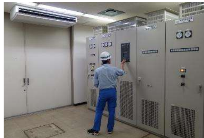
電気設備の点検の様子
