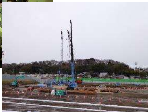
建設中のちば野菊の里浄水場（第Ⅱ期）
