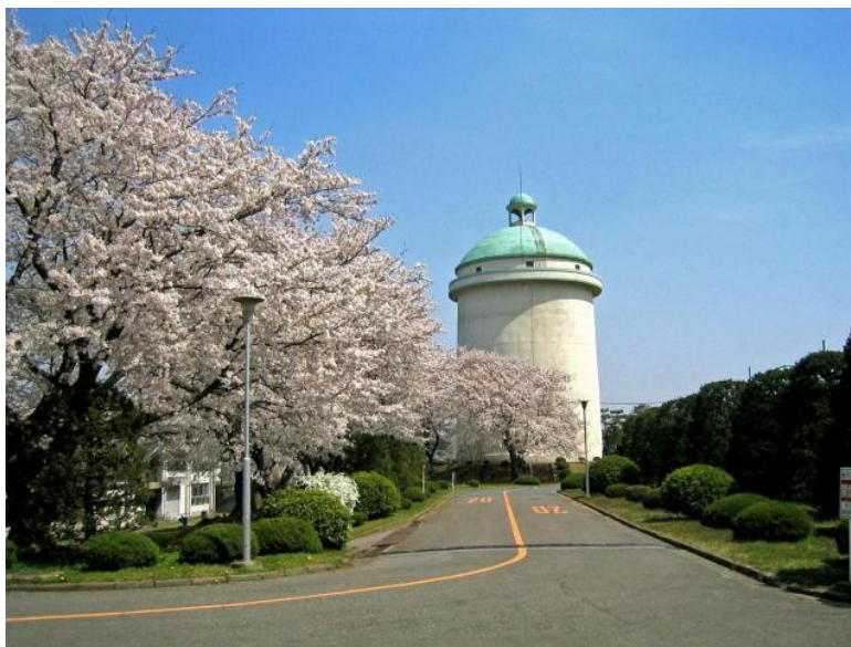
栗山浄水場配水塔
