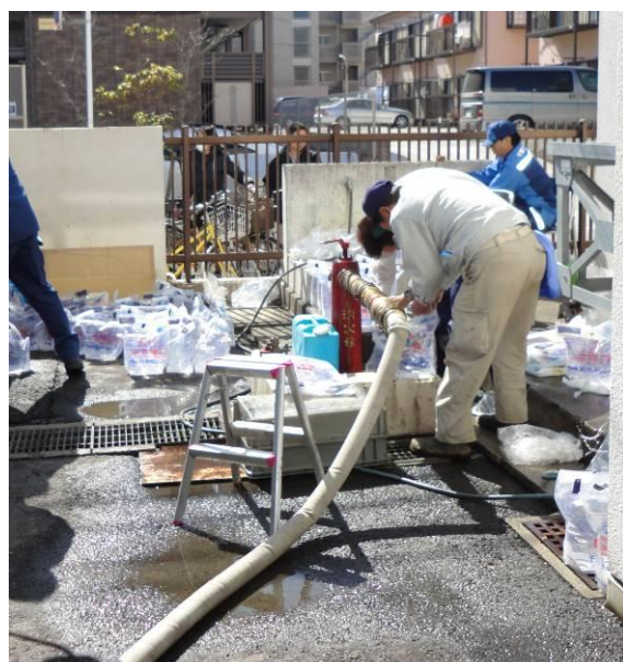
実際の応急給水活動 (東北地方太平洋沖地震発生後、浦安市内)
