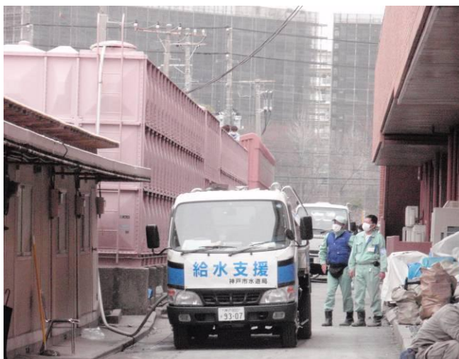
マンションの貯水槽への給水（神戸市水道局の給水支援車）
