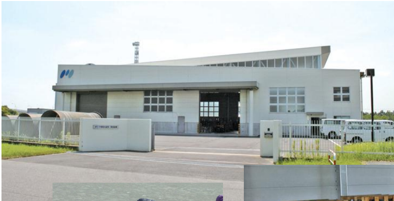
資材倉庫と備蓄物資 (千葉市美浜区)
