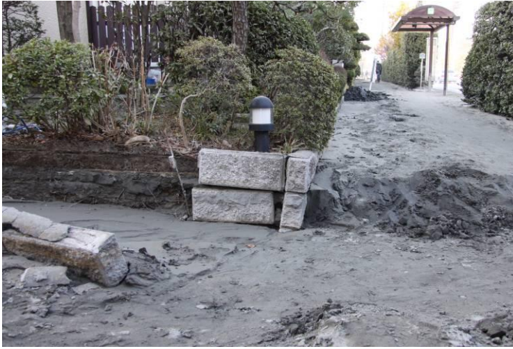
液状化現象による砂の噴出のため、歩道全面が埋没
