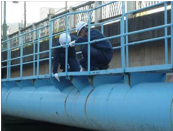
水管橋の点検
