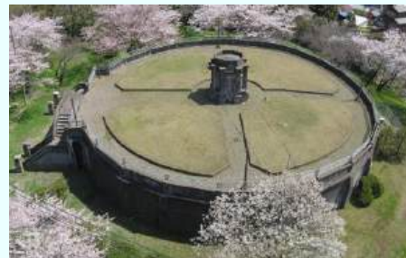
＜千葉分場1号配水池＞
