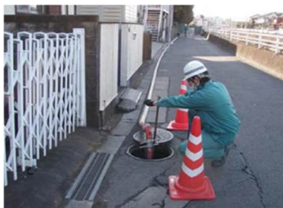
水道管の洗浄作業
