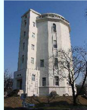
＜千葉高架水槽＞
