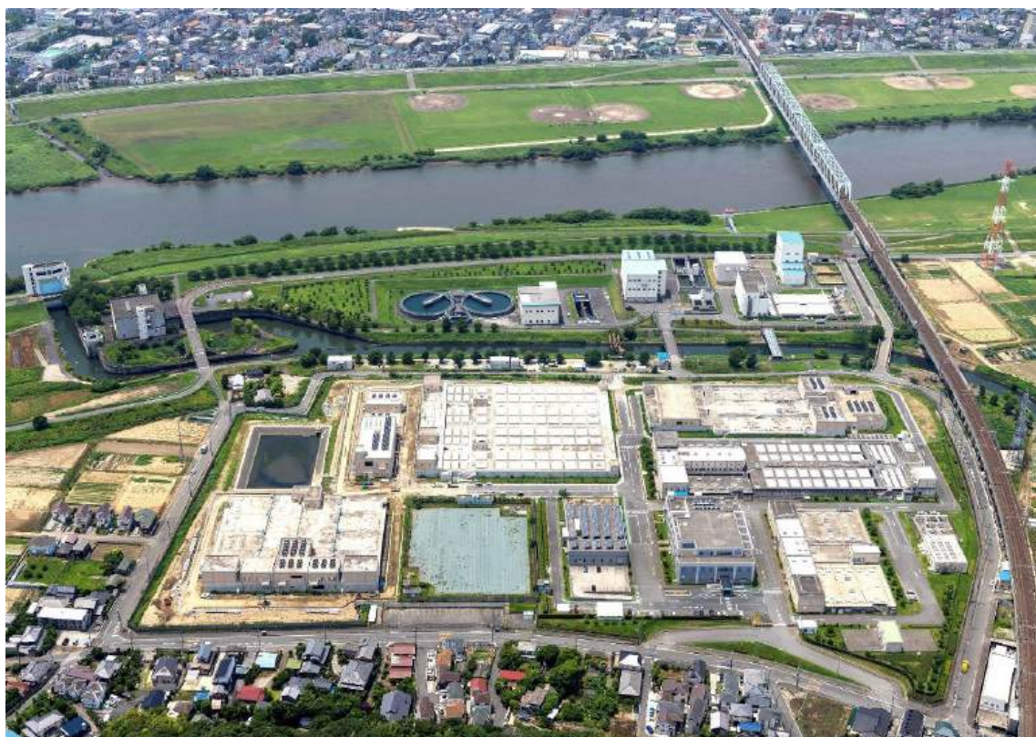
ちば野菊の里浄水場
