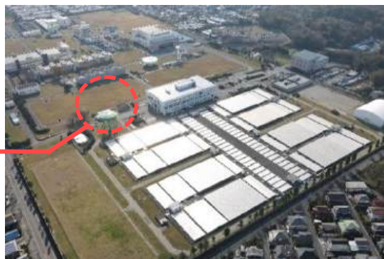
柏井浄水場西側施設洗浄水槽
