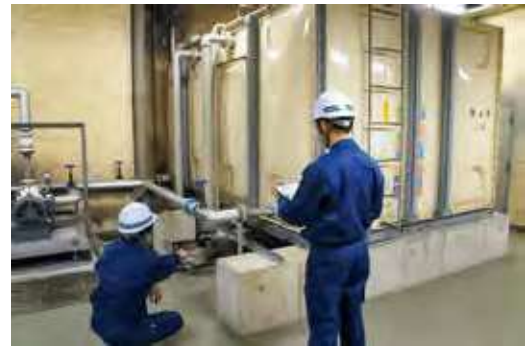
図5-12 貯水槽施設の点検
