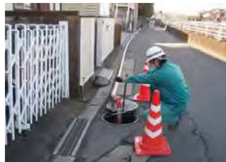
図5-11 水道管の洗浄作業
