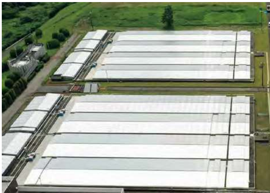
図3-7 浄水場の覆蓋化
