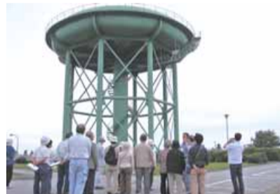
▲UFO...!? 浄水場にはおもしろい施設がたくさんあります。(柏井浄水場)
