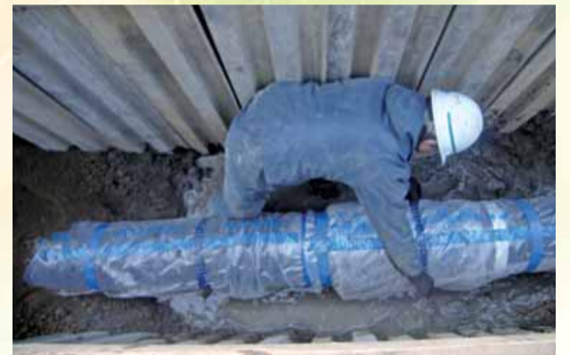
▲耐震管の埋設工事
