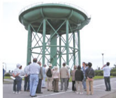
▲UFO…!? 浄水場にはおもしろい施設がたくさんあります。(柏井浄水場)
