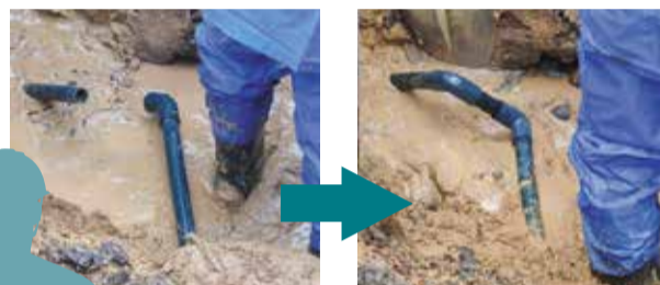
漏水修繕工事
