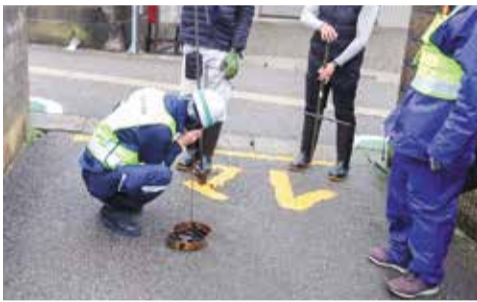
音聴棒による漏水調査
