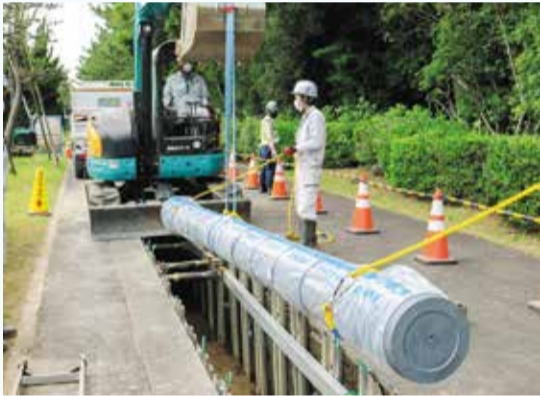
水道管の取替工事
