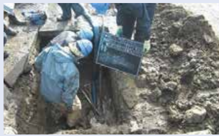
当時の工事の様子
