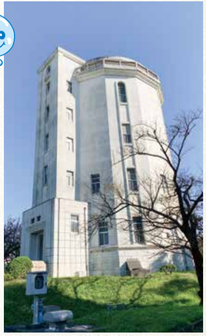
千葉高架水槽
