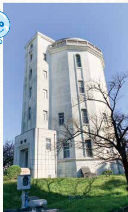
千葉高架水槽
