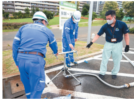
応急給水用仮設給水栓を用いた習志野市との訓練
