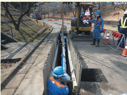
水道管取替工事の様子
