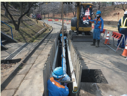
水道管取替工事の様子
