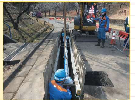
取替工事の様子
