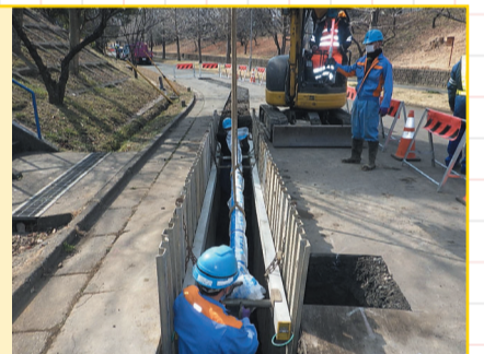
取替工事の様子
